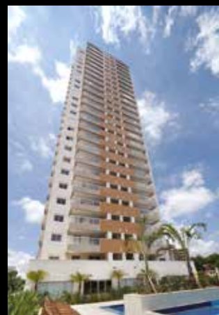
Ventura Rua dos Cafezais, 322 Jd. Prudência
