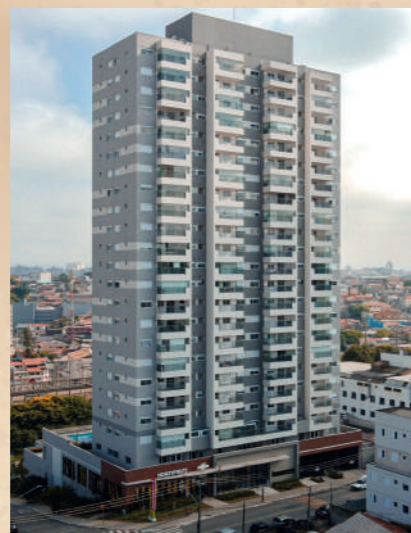
NEXT ASTORGA CONDOMÍNIO CLUBE RUA ASTORGA, 460 VILA GUILHERMINA
